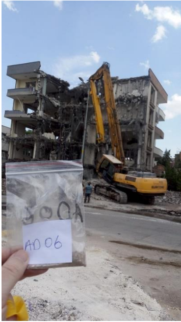
Şekil 11. Farklı özelliklerde noktalardan örneklemeler- a) Yıkımın örnekleme gününde devam ettiği bir nokta b) Yıkımın daha önce gerçekleştiği ancak hafriyatın kaldırılmadığı bir nokta c) Yıkımın daha önce gerçekleştiği ve hafriyatın kaldırıldığı bir nokta
