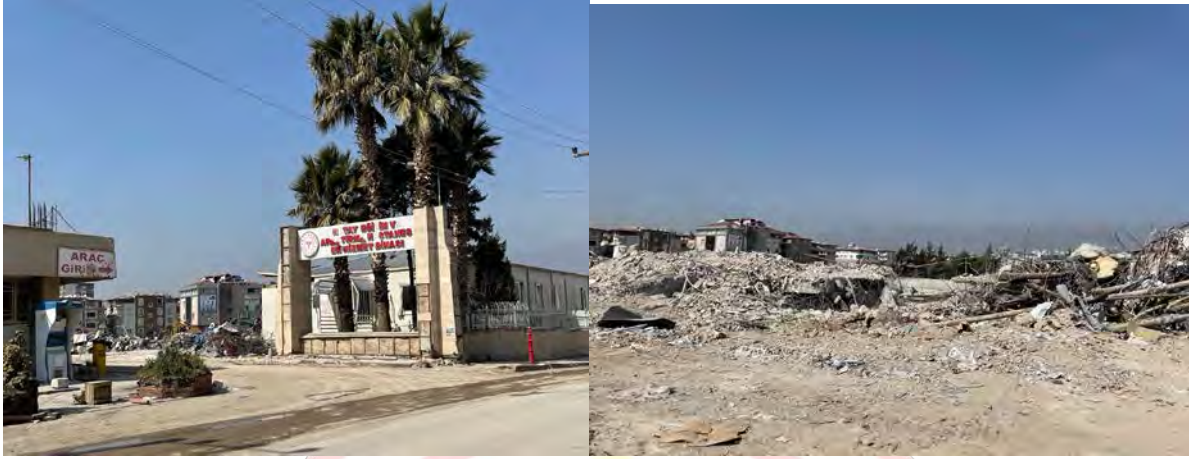
Hatay EAH Ek Bina (Eski Devlet Hastanesi)-Antakya
