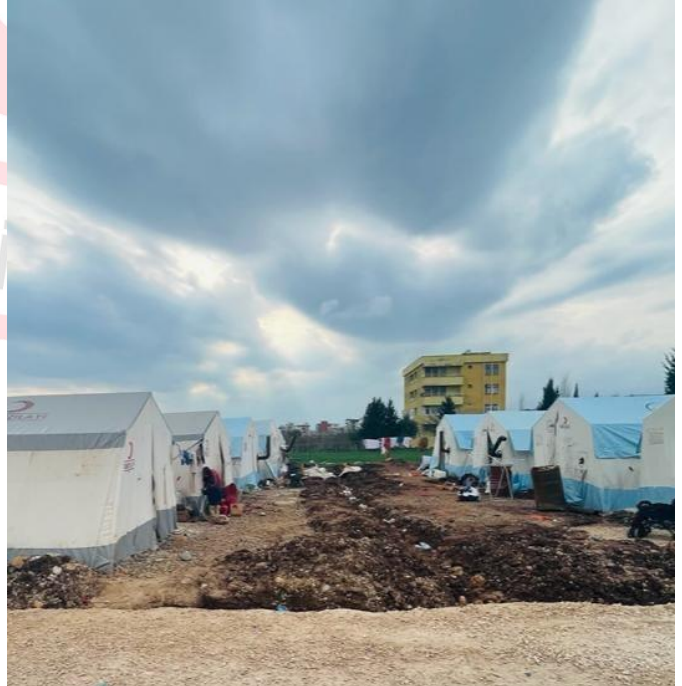
Ç1 drenaj kanalları
