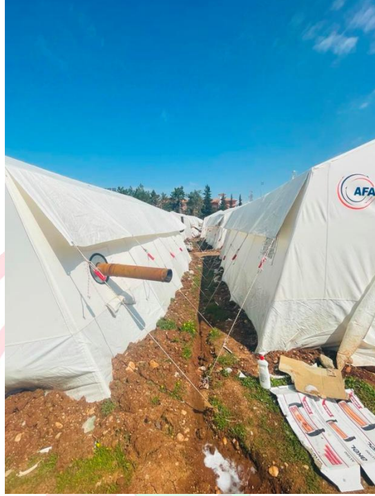
Kahta TMO Depo Alanı Çadır Kent drenaj kanalları
