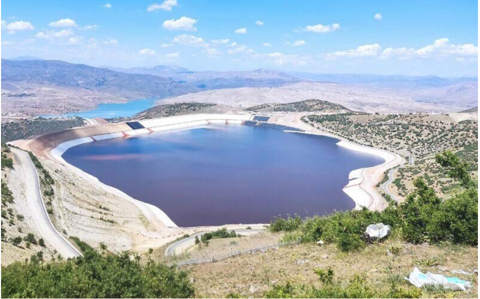
Fotoğraf 12. İliç'teki Çöpler Altın Madeni atık depolama havuzu.
