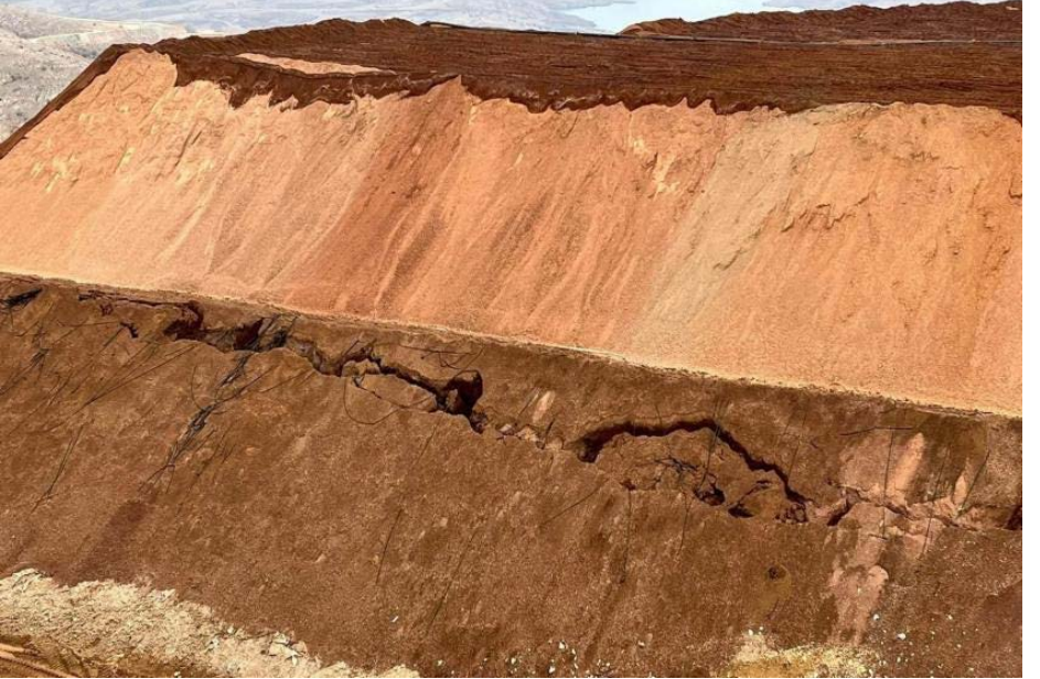
Fotoğraf 4. İliç altın maden ocağında meydana gelen toprak kayması öncesi sabah saatlerinde madenciler tarafından çekilen yığın lıç alanındaki çatlakları gösteren fotoğraf bilirkişi raporunda delil olarak yer aldı.
