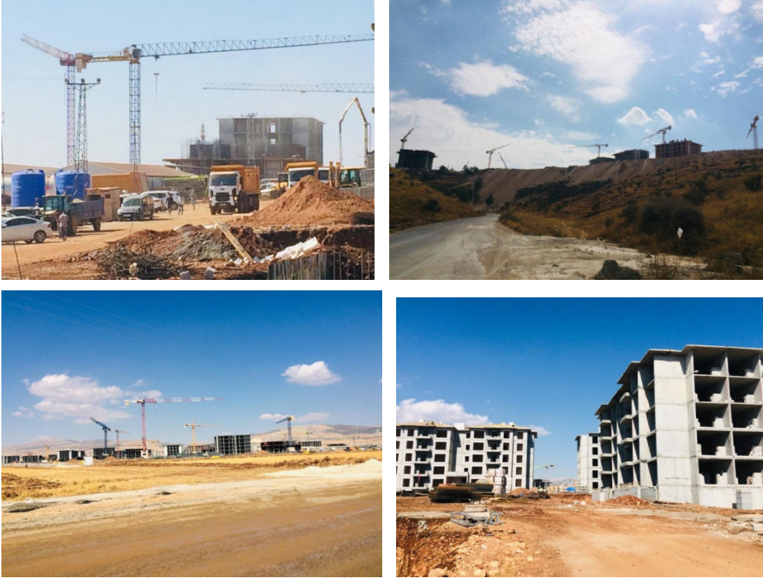
Fotoğraf-3.4: Toplu Konut İnşaat sahası
