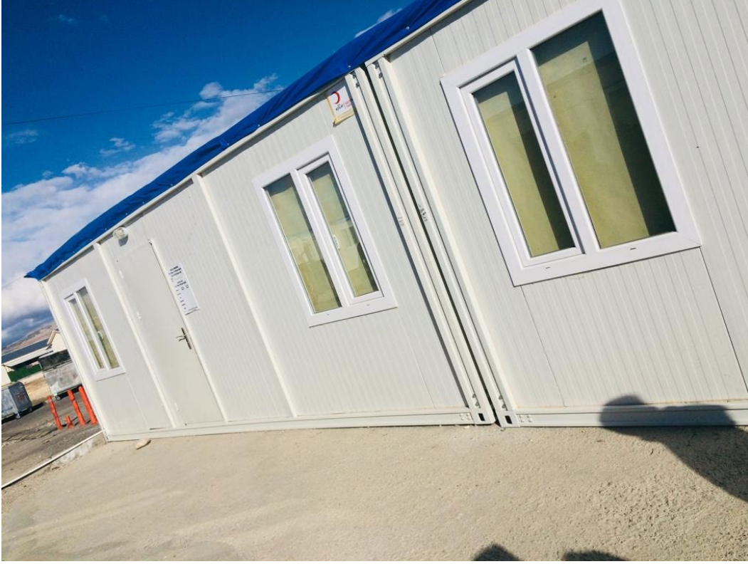
Fotoğraf-1.3: Vartana Konteyner Kenti ASM (Herhangi bir yükselti temel vb olmadan zeminle aynı seviyeye yerleştirilmiş).
