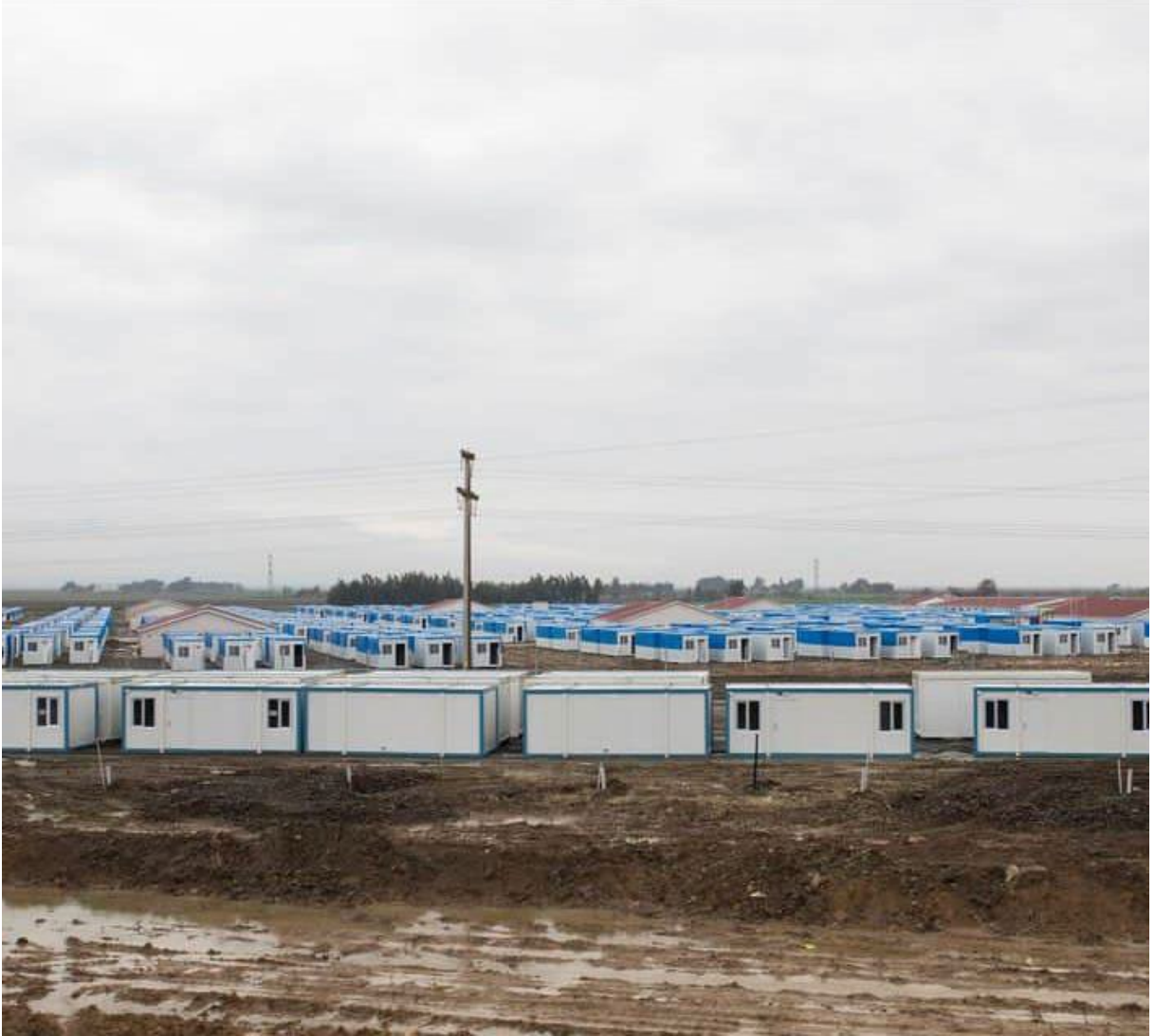
Fotoğraf-11.3: Antakya Üzümdalı mahallesinde mültecilerin yerleşimi için hazırlanan 3182 konteynirden oluşan kamp alanı
