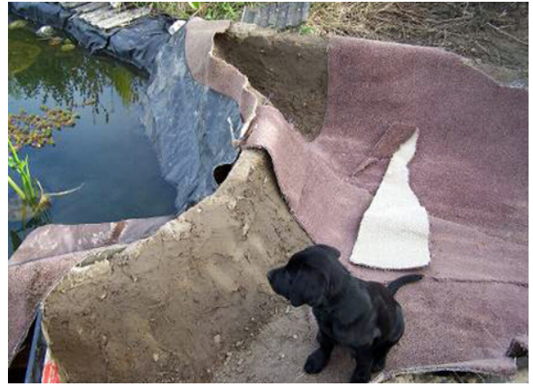
Fotoğraf 3- Sıvayı korumak için halı koyma. Kaynak: http://www.ecodiy.info/reedbed/ (112).
