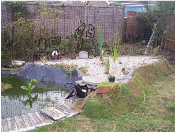
Fotoğraf 5- Bitmiş bir yapay arıtma sazlığı ve depolama havuzu örneği. Kaynak: http://www.ecodiy.info/reedbed/ (112).
