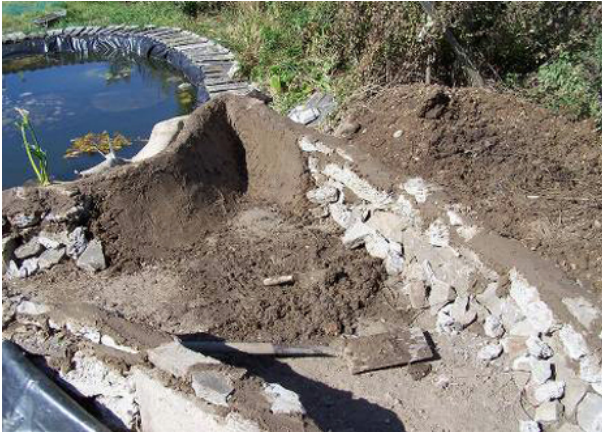
Fotoğraf 1- Yapay arıtma sazlığı göleti duvarlarının yapılması. Kaynak: http://www.ecodiy.info/reedbed/ (112)
