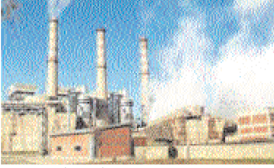
Yatağan Termik Santrali
